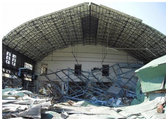
津波により建屋が倒壊したエヌエスオカムラの旧工場
