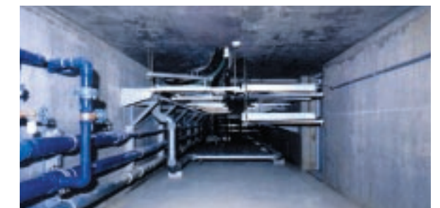
地下トレンチのメイン通路。高さ約1.9m、幅約3.7m。
