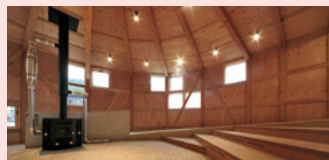
薪ストーブの煙突熱を利用した熱循環 装置
