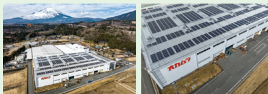
御殿場事業所の太陽光パネル
