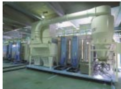
関西岡村製作所の粉体塗装ライン
