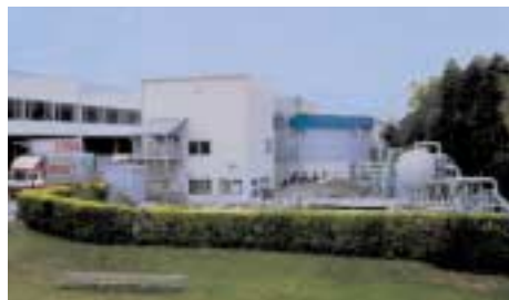
富士サイトの排水処理設備
