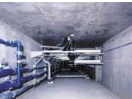
地下トレンチのメイン通路。高さ約1.9m、幅約3.7m
