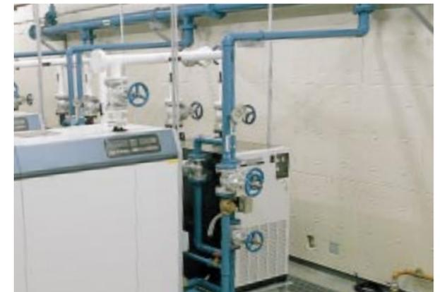
壁に吸音材を設置したコンプレッサー室
