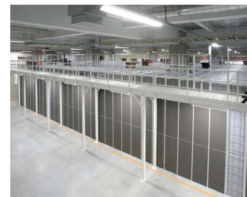
床から隙間なく積み上げられたピン(コンテナ)
