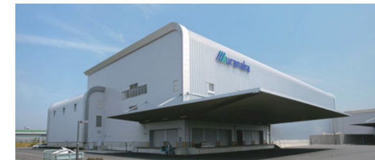
上 / 総合センター全景〈オフィス棟（右）、ロジスティック棟（中央）、研究開発棟（左）〉 下 / ロジスティック棟
