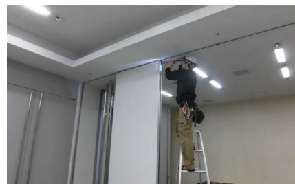
移動間仕切りの点検の様子
